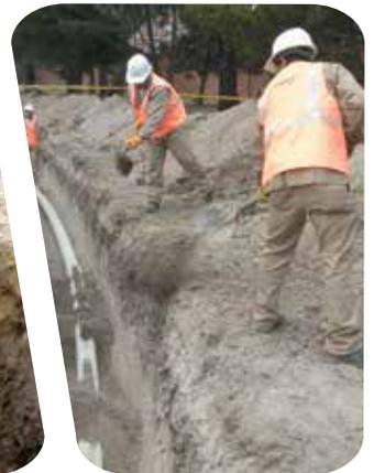
Los materiales adecuados para el encamado pueden ser triturado de roca (angular), tamaño máximo de 3/4", canto rodado, tamaño máximo 1.1/2", arena lavada, arenilla, recebo fino o material proveniente de la excavación si es adecuado. Su selección dependerá de la disponibilidad local y de la presencia o no de nivel freático, caso en el cual debe usarse el primero.
