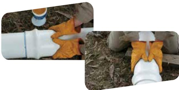
La Tubería BIAxIAL® de PAVCO WAVIN puede ser ensamblada en el borde de la zanja y luego instalada en el fondo como se muestra en las siguientes imágenes.
