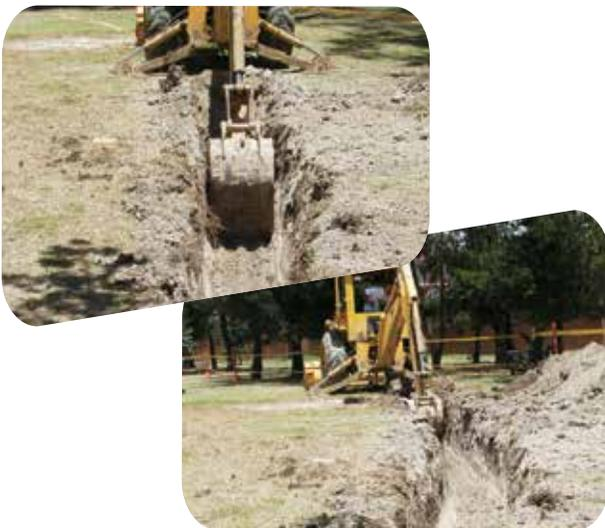
**Nota:** Cuando hay agua sobre el fondo de la zanja debe evacuarse para mantener la zanja seca hasta que la Tubería sea instalada y rellena al menos un diámetro sobre la clave de la Tubería para evitar flotación.
